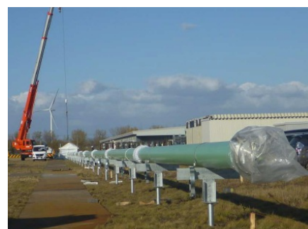
超電導管敷設作業
