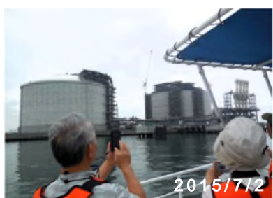
「躍進する石狩湾新港」 海上から眺める石狩湾新港
