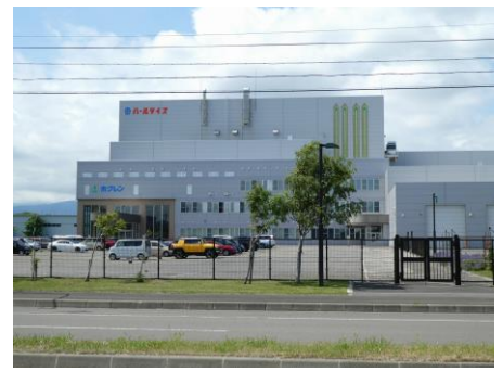
ホクレンパールライス工場
